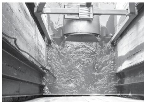
Завершена реконструкция двух участков коллекторов — по ул. Московской и по ул. Нарымской. Собственными силами Горводоканала завершена реконструкция Загородного коллектора диаметром 2500 мм общей протяженностью 3,46 км. Коллектор обеспечивает транспортировку всех стоков от Новосибирска, Бердска, города Оби, Академгородка и других муниципальных образований Новосибирского района от главной насосной станции до очистных сооружений канализации.
